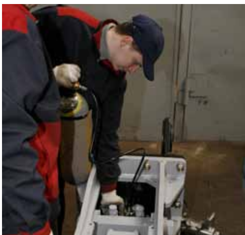
Заправка гидромолота азотом
