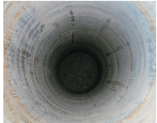
Foro di perforazione Drilling hole
